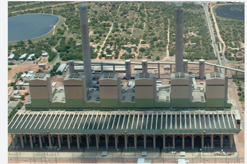
Source: Veolia and Thermowatt
