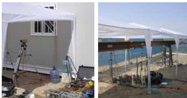
Figs. 11 y 12. Instrumentación y proceso de la prueba de carga.
