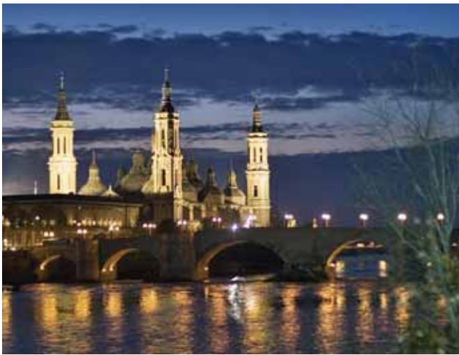
Fig. 1. Puente de Piedra en Zaragoza.
