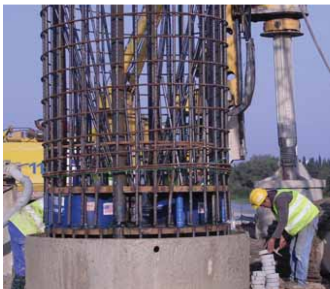
Fig. 10. Célula bidireccional de Osterberg incorporada a la armadura del pilote.
