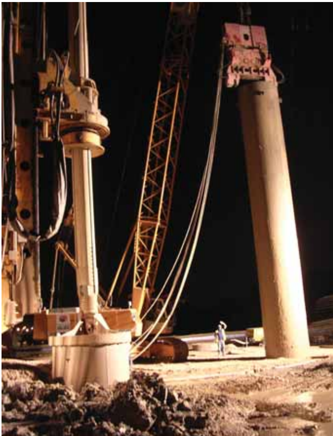
Fig. 9. Ejecución de pilotes encamisados in situ.
