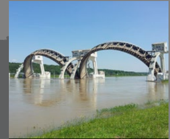
Renovatie Stuwensemble Nederrijn & Lek, the Netherlands
