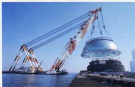
(d) The dome lifted from the barge.
