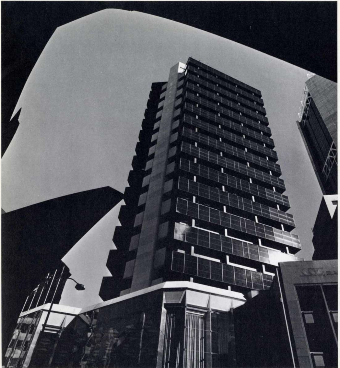
Fig. 9 CBA Centre tower (Photo : Max Dupain)
