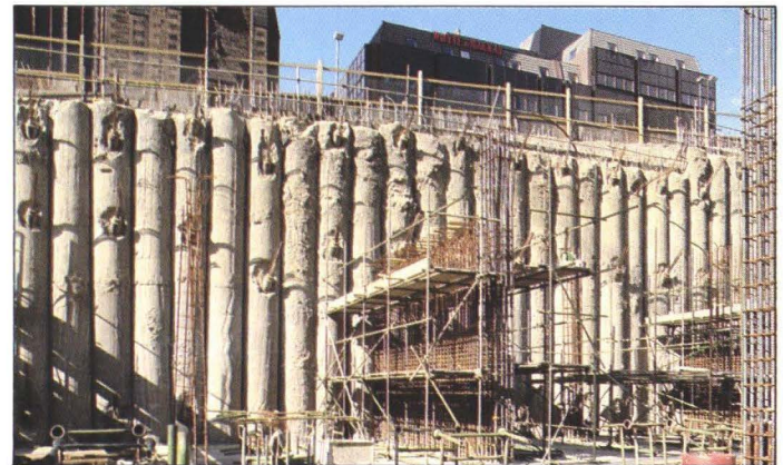
Secant pile wall
